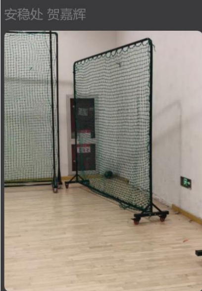
安稳处 贺嘉辉 体育馆篮球场，消火栓箱体被遮挡，防火门已 机房未上锁
