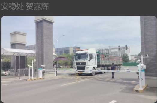
安稳处 贺嘉辉 校医院拉渣土进场
